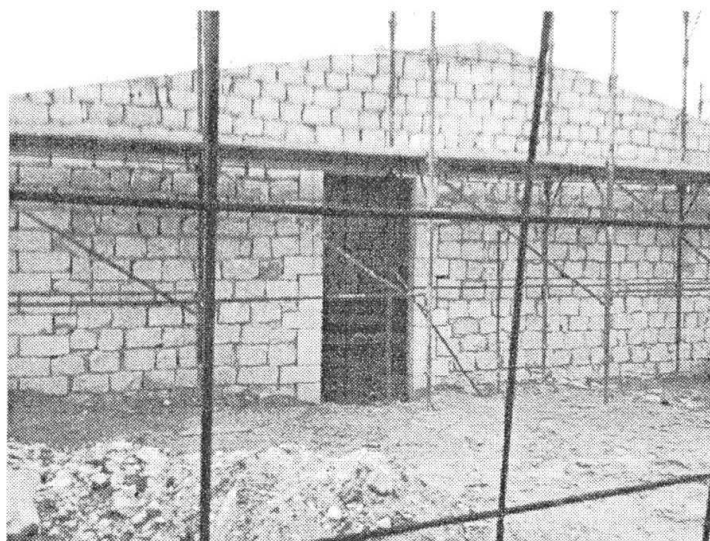
I lavori di ristrutturazione nella villa Lombardo sul litorale ispicese
